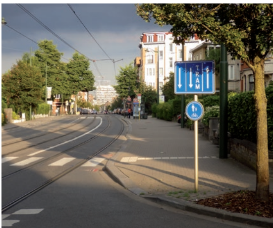
Figure 40 – Chaussée de Gand – Utilisation d'un panneau D10 à hauteur des arrêts des transports en commun.
