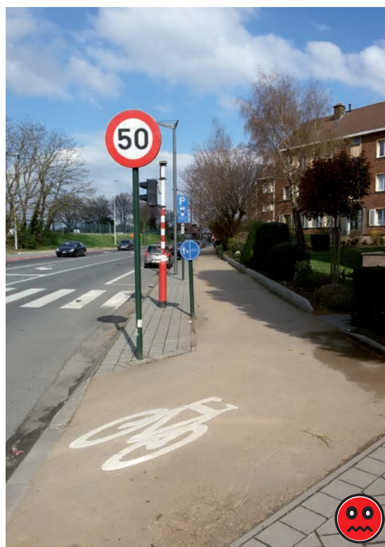
Figure 31 – La partie réservée aux piétons n'est pas égale à la zone-tampon (Chaussée romaine) – Les poteaux d'éclairage constituent des obstacles sur le trottoir, qui est déjà sous-dimensionné, et des obstacles (temporaires) entravent le libre accès à la piste cyclable. Une suppression des emplacements de stationnement aurait laissé suffisamment d'espace disponible pour un aménagement conforme pour les piétons et les cyclistes.
