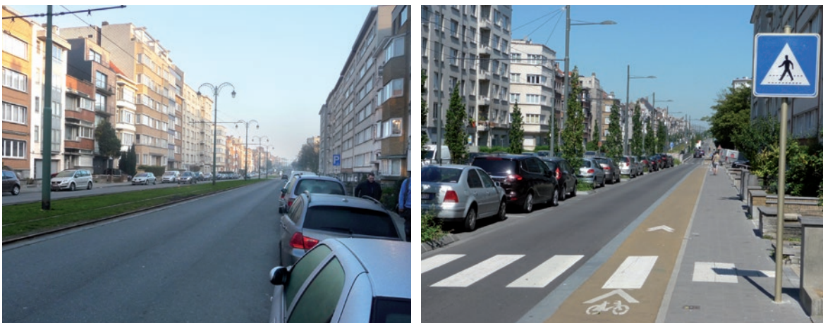
Figure 27 – Avenue Charles Woeste – Absence d’infrastructure cyclable avant travaux (photo de gauche) et création d’une piste D9 unidirectionnelle de 1 m 10 après travaux (photo de droite).
