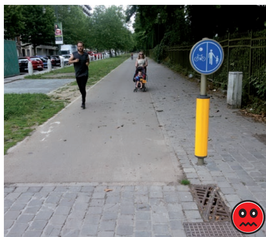
Figure 42 – Av. de la Renaissance, D9 – Avec cet aménagement, indiqué par un panneau D9, les piétons vont systématiquement utiliser la partie réservée aux cyclistes. Ce phénomène est dû à l'utilisation d'un matériau plus confortable pour cette piste cyclable que pour le trottoir.
