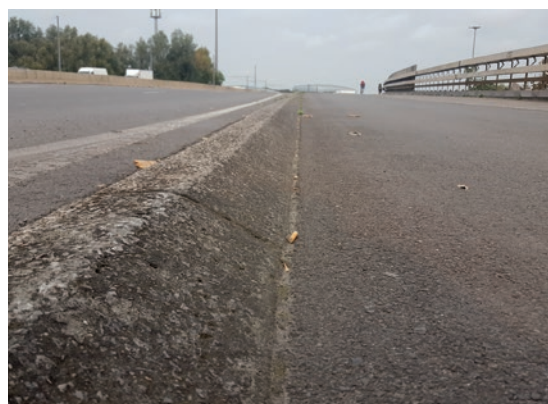
Figure 7 – Pont Van Praet – Bordure asymétrique.
