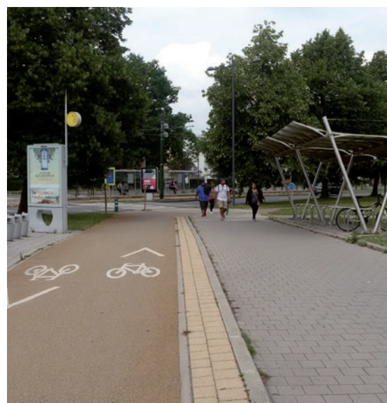
Figure 10 – Boulevard Léopold III – Une séparation physique entre la piste cyclable et le trottoir permet d'éviter que cyclistes et piétons ne se retrouvent accidentellement sur un aménagement qui n'est pas le leur.
