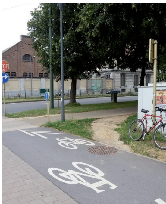
Figure 21 – Boulevard de la Plaine – Les cyclistes recherchent souvent le chemin le plus court, même si il n'est pas revêtu. Dans l'exemple ci-dessus, un chemin «sauvage» a progressivement vu le jour, parce que les cyclistes désireux de tourner à droite ont systématiquement opté pour le chemin le plus facile (le plus logique).
