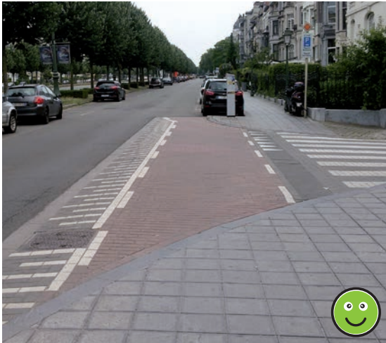
Figure 17 – Avenue de Tervueren – Transition de la fin de la piste cyclable vers la circulation mixte, en toute sécurité pour les cyclistes.
