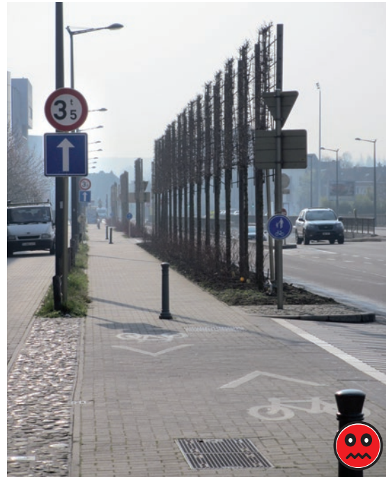
Figure 50 – Les chevrons et vélos n'auraient pas dû être marqués, l'espace est partagé entre piétons et cyclistes.
