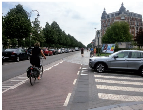
Figure 47 – Avenue de Tervueren – Traversée pour cyclistes et piétons entre 2 aménagements indiqués par un D10.
