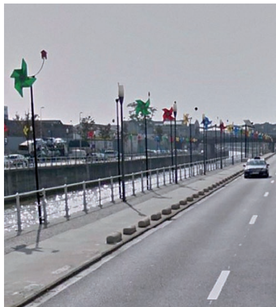
Figure 24 – Quai des Charbonnages, ancienne situation : l'aménagement cyclable disposait du signal D7 – Il aurait mieux valu aménager toute la largeur comme une seule zone, éventuellement avec un statut F99a, en fonction des flux de cyclistes et de piétons.
