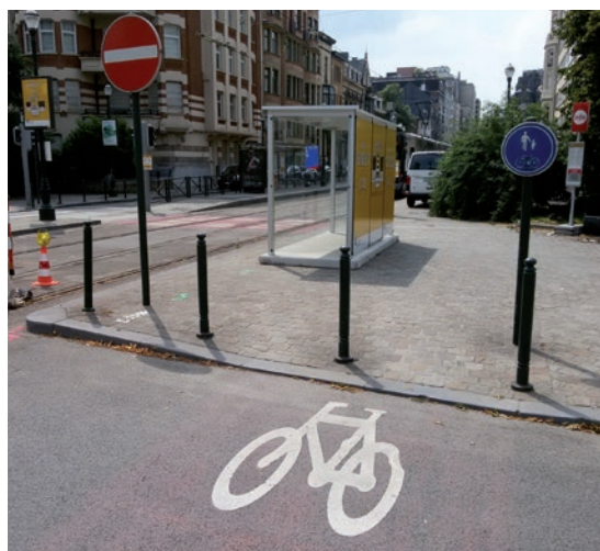
Figure 35 – Arrêt de tram «Cambre-étoile» – À hauteur de cet arrêt figure un D10 qui, à l'avenir, sera remplacé par un signal F99a.
