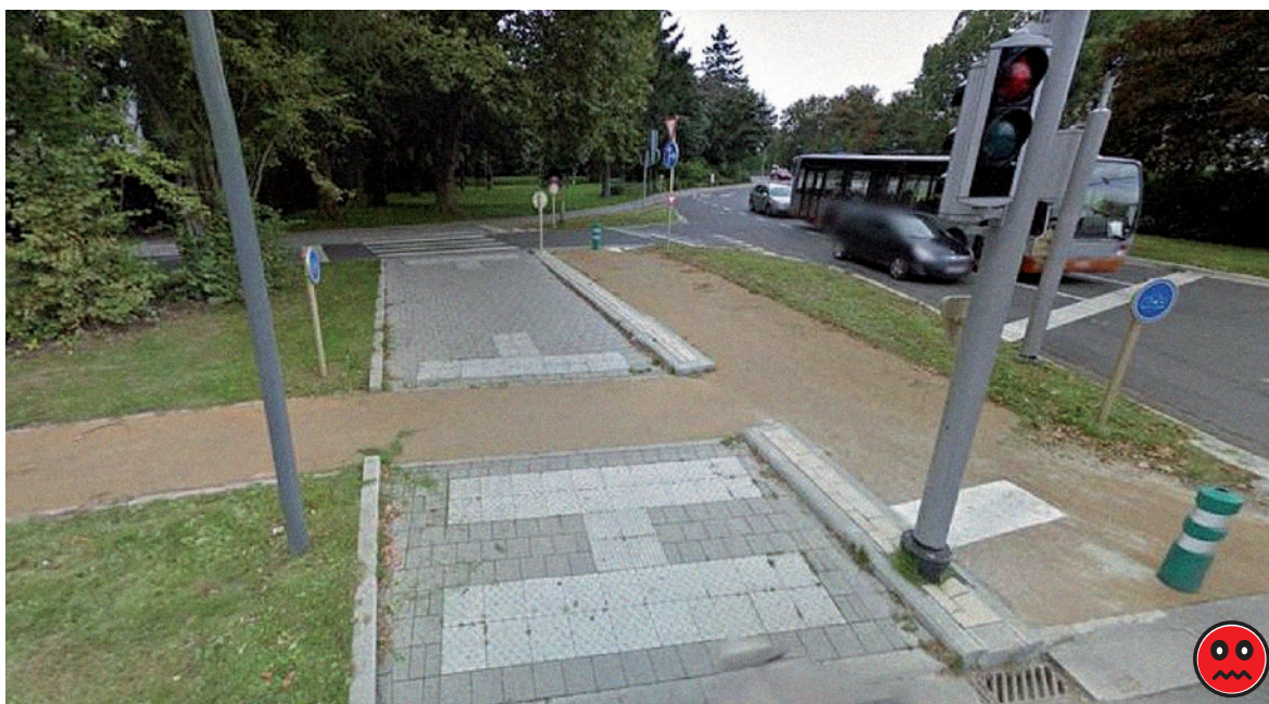
Figure 20 – Boulevard Léopold III – Lorsque deux pistes cyclables se croisent, la forme de ce croisement doit permettre aux cyclistes de rouler d'une piste cyclable à l'autre en toute sécurité. Elles ne peuvent pas présenter d'angles de 90°.
