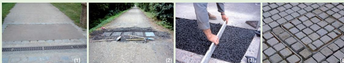
**Figure 17 – Équipements de comptages par dalles installées sur des sentiers au revêtement souple (1) et (2), en sol artificiel sous des revêtements asphaltés (3) ou en revêtements pavés (4) (source: Eco-compteur, 4must.be)**
