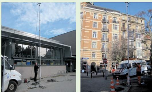
Figure 5 – Exemples d'installation d'une caméra vidéo sur mât (source : CRR)
