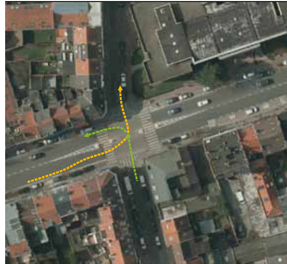
Fig. 4.13. un îlot refuge pour une traversée piétonne en 2 temps apporte également un confort et une protection aux cyclistes en attente de tourner à gauche dans le carrefour (av. d'Auderghem). Source : geoloc.irisnet.be.
