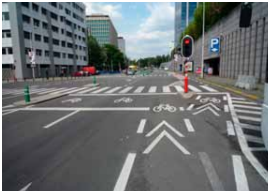
Fig. 5.45. Au boulevard Pachéco, les cyclistes continuant tout droit ne sont en conflit avec aucun autre mouvement motorisé. Ils peuvent le faire librement, en cédant le passage aux piétons traversant.
