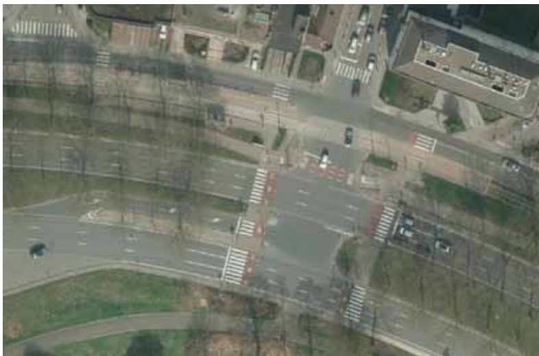
Fig. 5.27. La piste cyclable bidirectionnelle de l'avenue de Terwuren, à la hauteur de l'av. J. De Trooz, dispose d'une phase verte sans conflit par rapport aux véhicules tournant à gauche. Le conflit avec les véhicules circulant sur l'avenue en direction du centre et tournant à droite est malheureusement maintenu, bien que ceux-ci soient invités à rejoindre l'allée latérale quelques centaines de mètres en amont. Source : geoloc.irisnet.be
