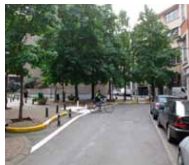
Fig. 3.8. St-Gilles, rue Bosquet x Dejoncker, la bordure bateau aménagée pour la traversée du dispositif par les cyclistes est mise en évidence par une peinture blanche.
