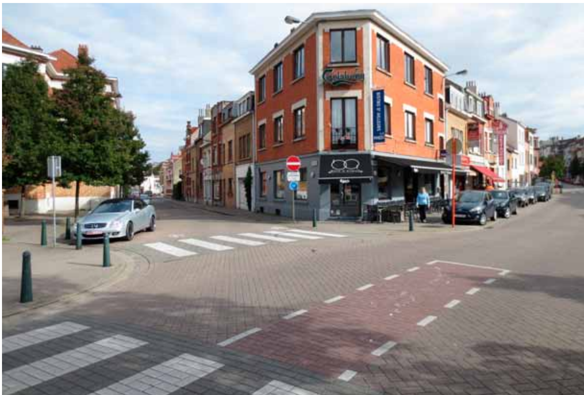
Fig 4.24. Ce petit dispositif permet aux cyclistes, le cas échéant, d'attendre au centre de la chaussée avant de traverser (Roche fatale x Roodebeek).
