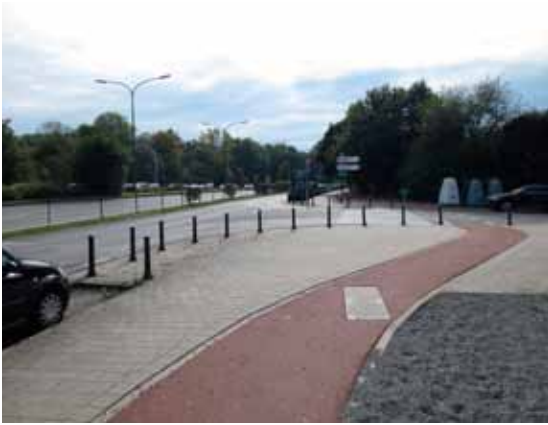
Fig. 4.9. En présence d'une allée latérale le long des grands boulevards, le plateau peut inclure tout le carrefour (bd de la Woluwe x Pierre de Cock). Dans le cas illustré, le dévoiement de la piste cyclable, bien que d'un rayon de courbure confortable, n'est pas nécessaire.
