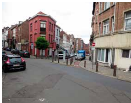
Fig. 3.16. Îlot aménagé en dur à l'entrée d'un SUL, protégeant les cyclistes d'un mouvement de tourne-à-gauche "à la corde" des véhicules.
