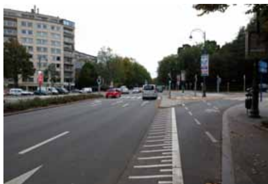
Fig. 5.13. Le by-pass du feu est aménagé en plateau, de sorte que le trafic qui aborde la piste cyclable séparée ne puisse le faire qu'à vitesse réduite (carrefour Roosevelt – Lloyd Georges).
