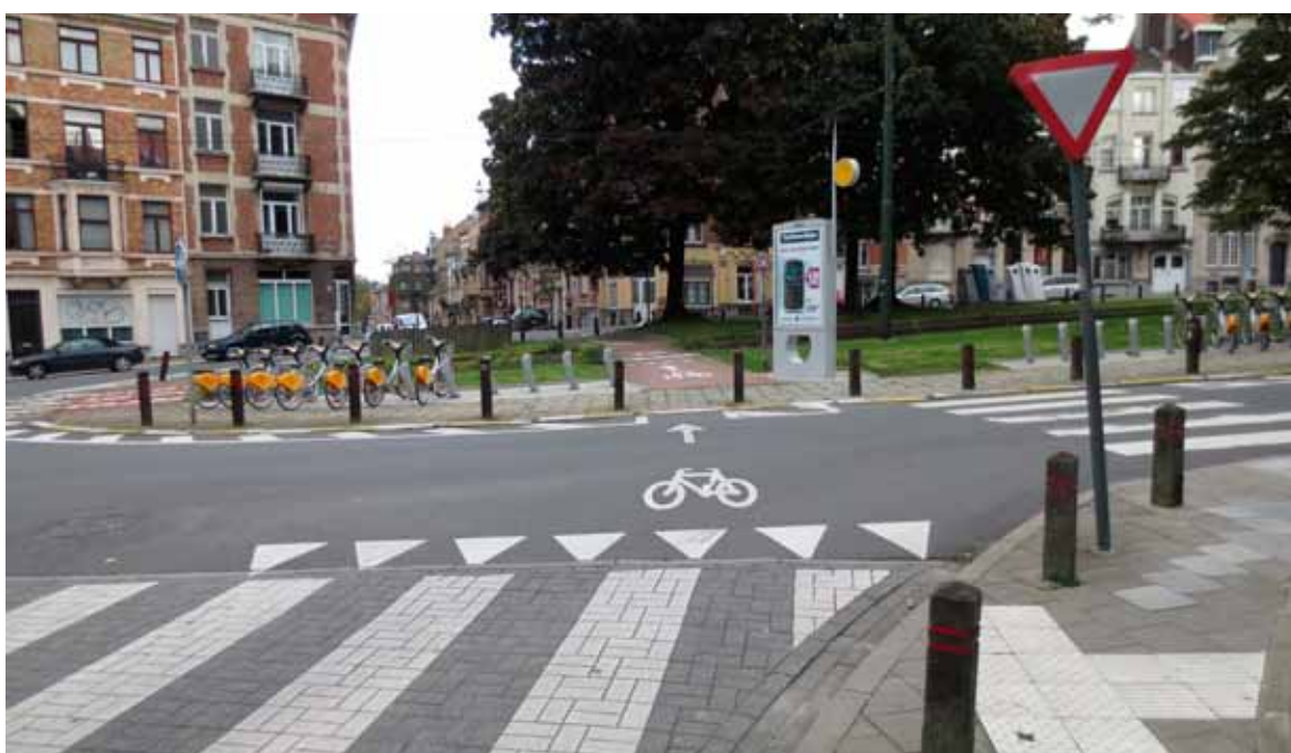
Fig. 4.27. Le trafic automobile souhaitant continuer tout droit est renvoyé à droite vers le carrefour suivant. Les cyclistes peuvent traverser la berme et les rails de tram pour continuer tout droit (carrefour Rogier x Marckelbach x Vanderbussche).
