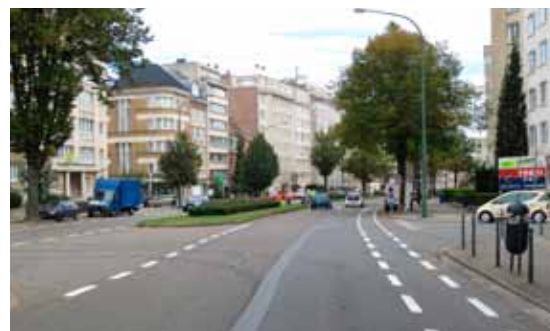
Fig. 4.3. La piste cyclable marquée est prolongée le long d'un axe prioritaire (av. de Broqueville).
