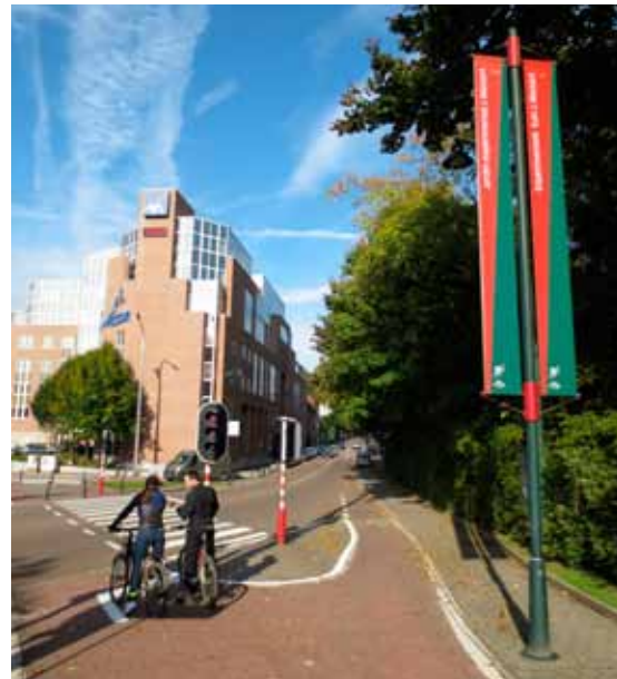
Fig. 5.46. Les cyclistes qui tournent à droite ne sont pas soumis aux feux. Voir également la figure 5.16. A noter que la cohabitation avec les piétons doit être soigneusement étudiée dans ce type de solution.
