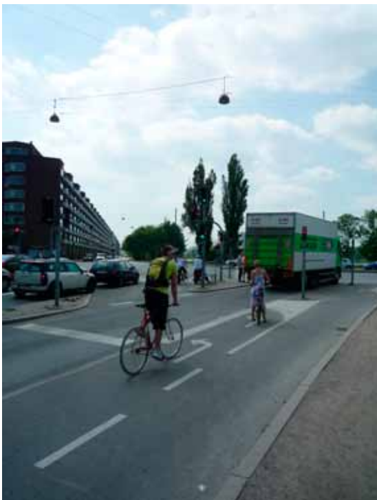
Fig. 5.52. Dans ce carrefour à Copenhague, la traversée par les cyclistes de l'important trafic de tourne-à-droite est organisée de telle sorte que les cyclistes qui vont tout droit ou tournent à gauche ne perdent pas une phase de vert au carrefour. Rouge pour les cyclistes au feu avancé (Nørre Søgade-Gyldenløvesgade).
