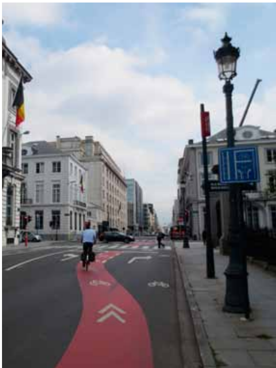
Fig. 5.36. Bien que le sas ne soit pas compartimenté, les cyclistes sont orientés vers la partie gauche ou la partie droite de celui-ci en fonction de leur destination. Dans ce cas particulier (rue de la Loi), la bande cyclable suggérée a été renforcée d'un revêtement rouge au travers de la bande de tourne-à-droite, car elle suit la trajectoire de la majorité des cyclistes.
