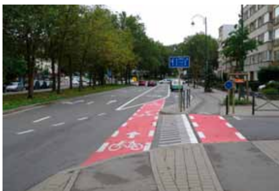
Fig. 5.8. Sur le boulevard Mettwie, à l'approche de la chaussée de Ninove, les cyclistes peuvent choisir entre la piste cyclable séparée, et, en parallèle, le site spécial franchissable ouvert aux cyclistes qui les amène dans la ZAC et leur permet de tourner à gauche en un temps.
