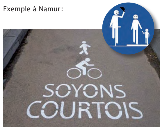
Figure 38 – Marquages de renforcement sur une piste D10 à Namur.
