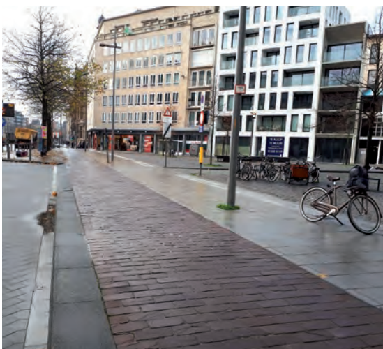
Figure 81 – Anvers, Aménagement de sortie avec piste cyclable séparée.
