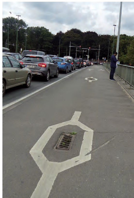
Figure 67 – Pont Van Praet – Les avaloirs sont indiqués par des marquages en relief (tout comme pour les potelets).
