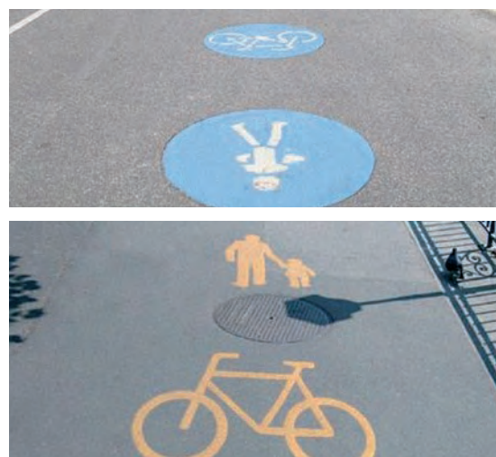
Figure 39 – Marquages de renforcement sur une piste D10 à Vienne et en Suisse.
