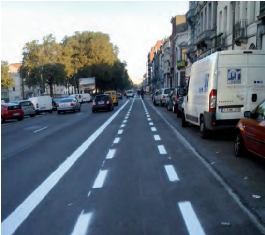
Figure 26 – Boulevard Poincaré – Emplacement de stationnement entre piste cyclable et trottoir.
