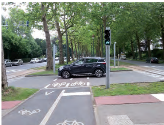
Figure 17 – Piste cyclable bidirectionnelle sur îlot central, Boulevard du Souverain – Sur cette photo, la piste cyclable bidirectionnelle n'est pas encore réalisée en couleur ocre.
