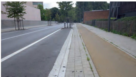
Figure 25 – Boulevard de la Deuxième Armée britannique, Forest – Emplacement de stationnement entre la chaussée et la piste cyclable.
