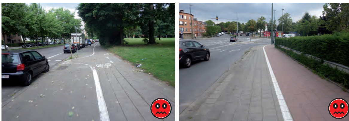
Figure 21 – Boulevard Maria Groeninckx-De May: « comment cela ne doit PAS être » – La piste cyclable et le trottoir ont ici été intervertis. Il n'est pas logique de faire circuler les piétons entre le trafic motorisé et les cyclistes.
