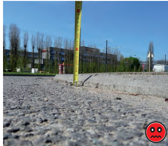
Figure 54 – Mauvais exemple de transition de la piste cyclable vers la chaussée.
