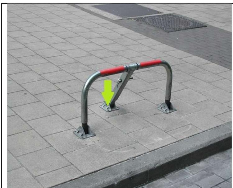
Les protèges parkings sont relevés au niveau du point d'ancrage dans le sol de la béquille de blocage du mécanisme.
