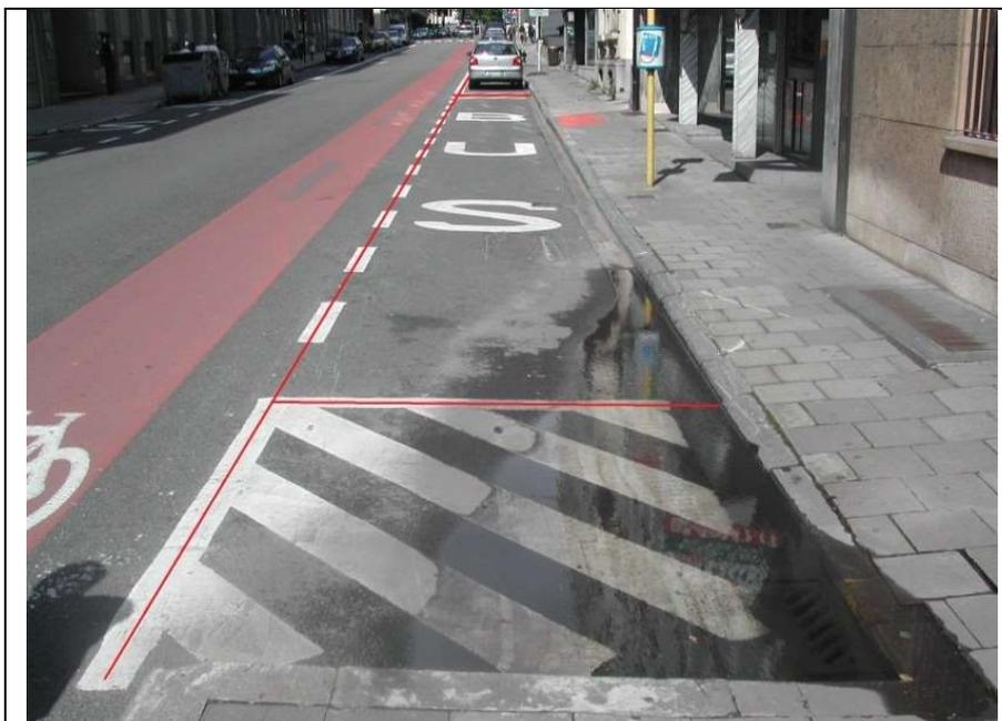
Les aires de stationnement correspondant aux arrêts de bus sont représentées dans la couche «750\_Arret\_bus» au moyen d'éléments linéaires. On relève les parties de contours qui ne coïncident pas avec des bordures ainsi que les lignes transversales.
