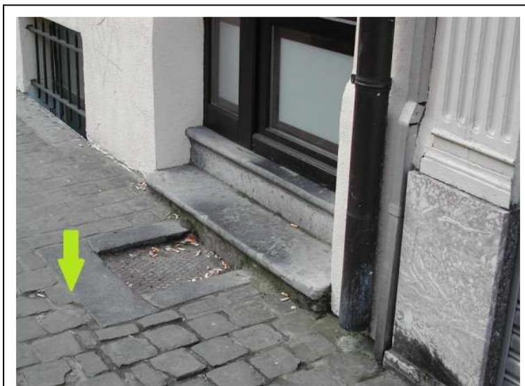
Les soupiraux situés en avant des entrées d'immeubles doivent être relevés et représentés au moyen de la cellule « BM286.2 ».
