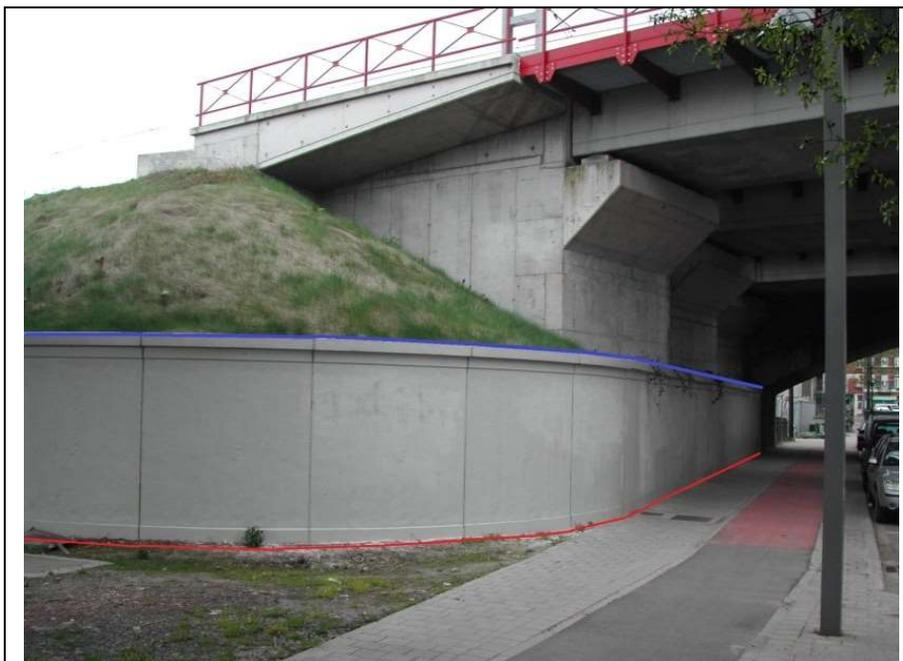
Le pied d'un mur de soutènement est représenté dans la couche « 270\_Mur\_soutènement » (ligne rouge). Le sommet d'un mur de soutènement est représenté dans la couche « 270\_Mur\_soutènement ».
