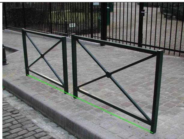
Alignement de garde-corps constitué de deux éléments. On relève les extrémités : « 337\_Garde\_corps »
