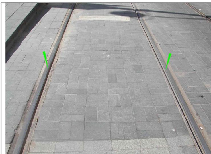
Le sommet de chaque rail de tram ou de chemin de fer est relevé sur sa face intérieure suivant les schémas ci-dessous :
