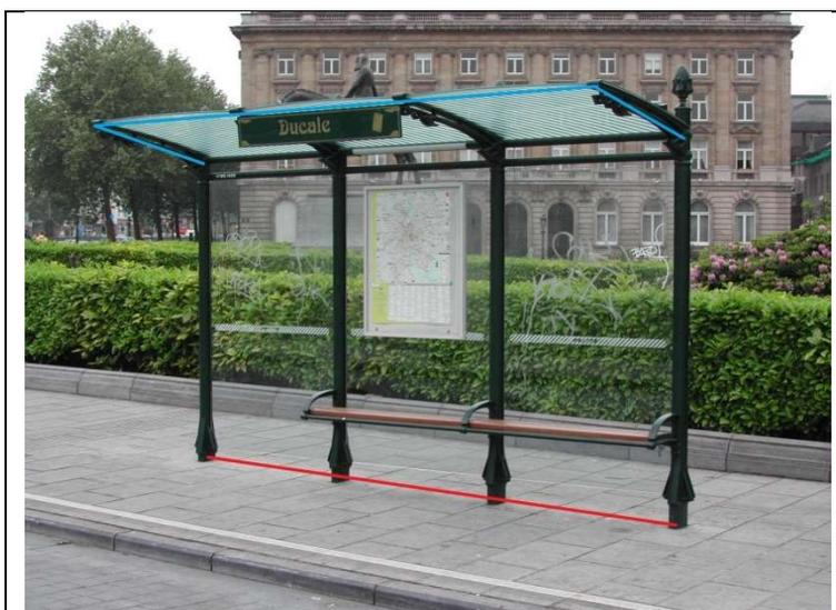
Les parois verticales des abribus sont relevées et représentées dans la couche «329\_Abribus\_parois » (ligne rouge) au moyen d'éléments linéaires. Le relevé de ces parties est effectué au niveau du sol.
