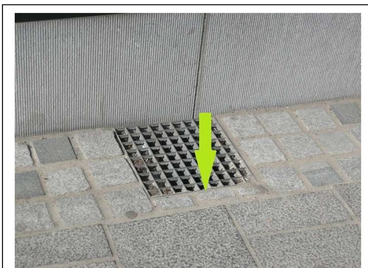
Les soupiraux  $\leq 1$  m distants de plus de 50 cm les uns des autres sont relevés individuellement au milieu du bord opposé à la façade. Ils sont représentés dans la couche « **286\_Soupirail** » au moyen de la cellule « **BM286.2** ».
