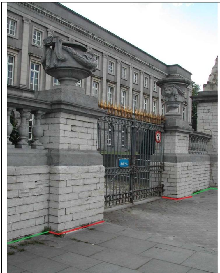
Les décrochements > 20 cm situés aux extrémités des murs et murets sont considérés comme des pilastres. Ils sont représentés dans la couche "213\_Pilastre" (lignes rouges).
