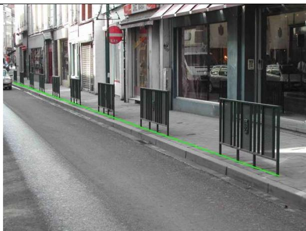
Alignement de garde-corps constitué d'éléments éloignés de moins de 3 m les uns des autres : « 337\_Garde\_corps »
