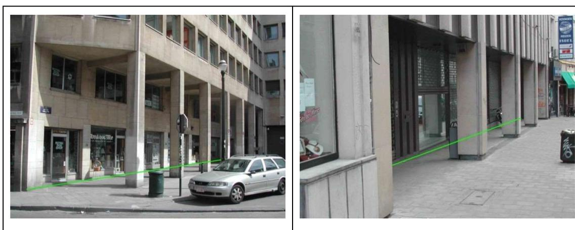
Galerie ouverte et passage couvert à lever, les piliers sont à lever et représenter dans la couche « 205\_Pilier »
