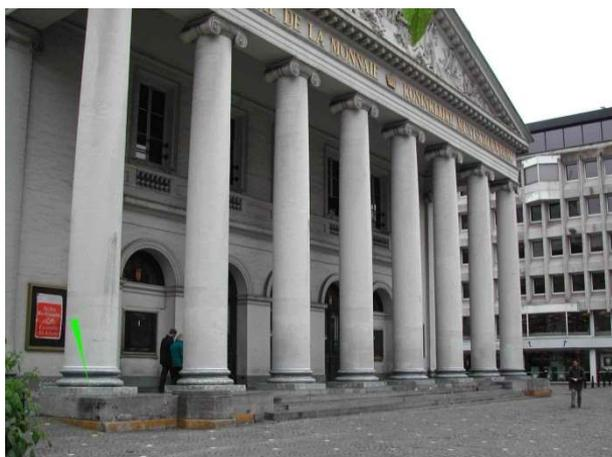
Les piliers dont l'une des dimensions est  $\leq 1\text{m}$  sont relevés à l'axe et représentés au moyen de points orientés
