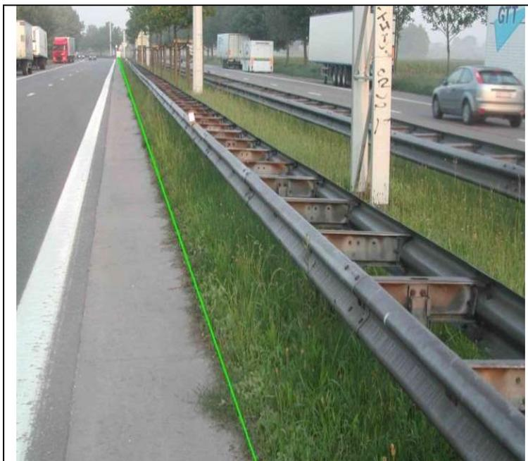
En l'absence de bordure, le bord route matérialisé ici par une bande de contrebutage est représenté dans la couche « 377\_Bord\_route »
