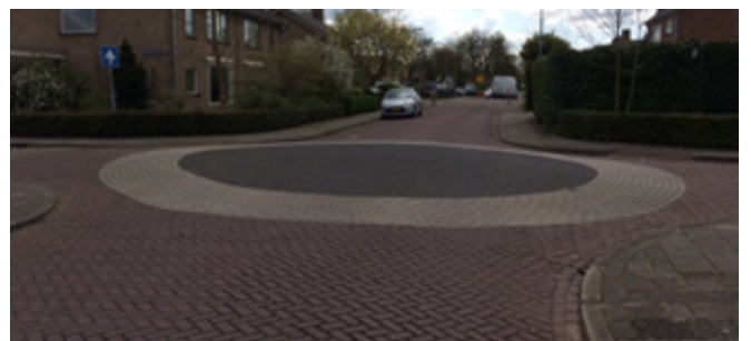
Figure 12 : Aménagement complètement franchissable (également appelé punaise)
