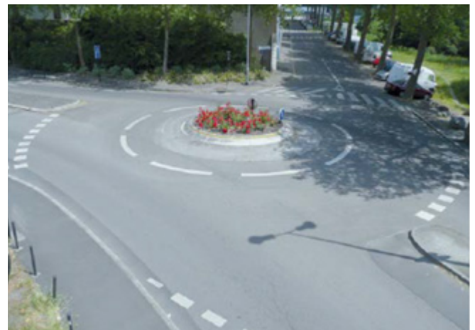
Figure 7 : Giratoire compact partiellement franchissable [CERTU 2010]
