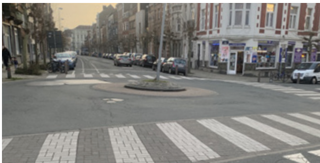
Figure 3 : Giratoire semi-franchissable (Schaerbeek)
